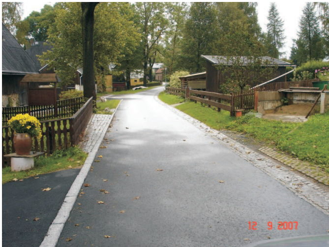
Ausbau Straße zur Alte Flugschule
