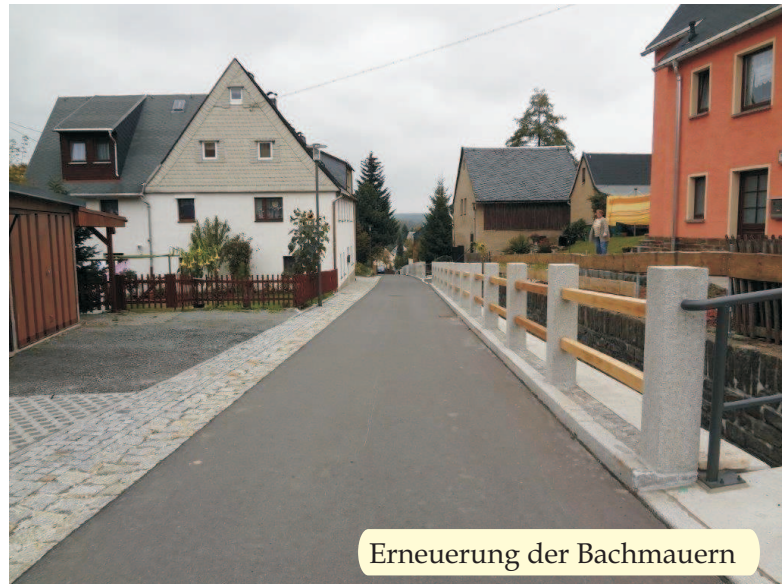
Ausbau Dorfstraße in Mauersberg
