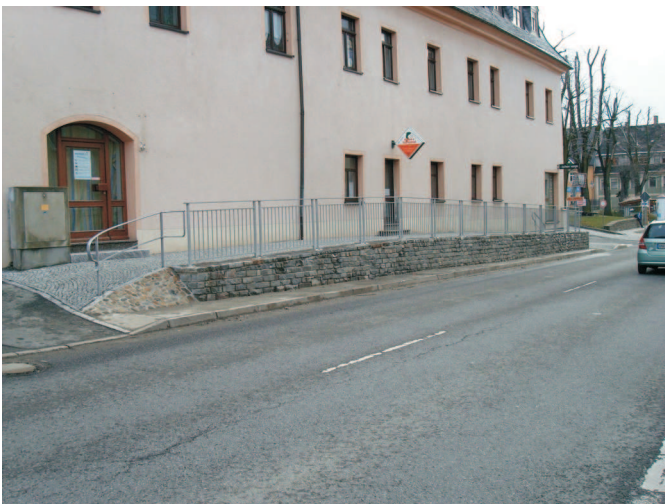
Ersatzneubau Stuetzmauer an der B 101
