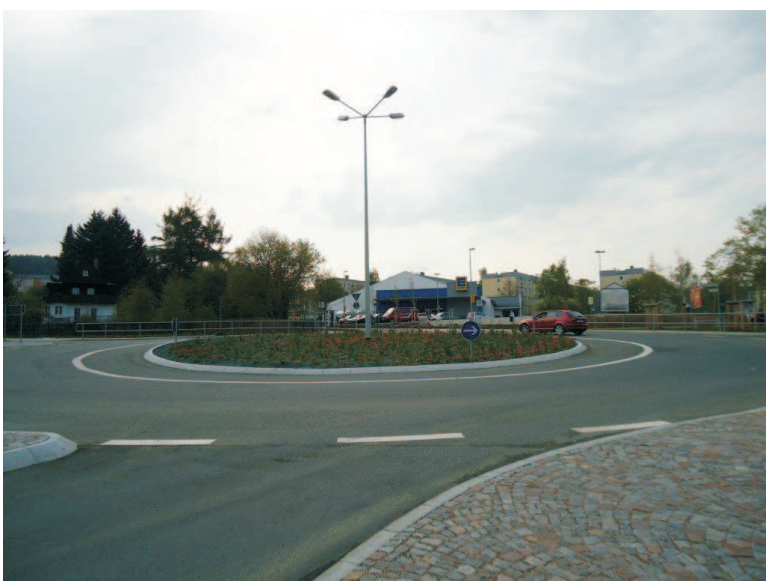
S 274 Ausbau in Schwarzenberg mit Knoten K 9130 Kreisverkehr
