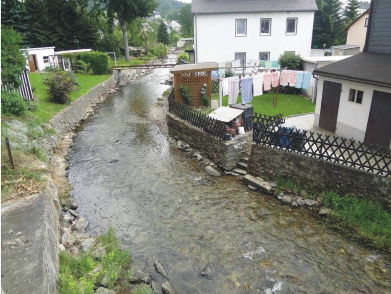
vor Baubeginn nach Hochwasserereignis 2013
