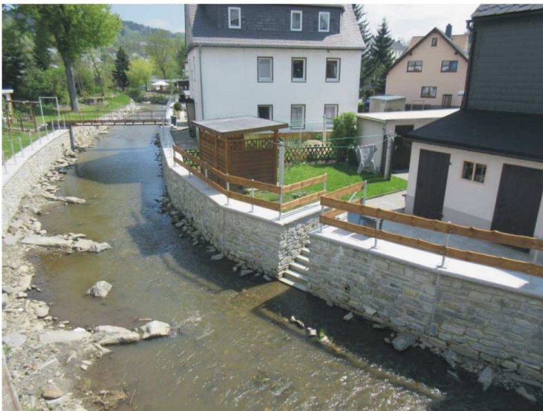
Fertigstellung der Baumaßnahme Jahr 2016
